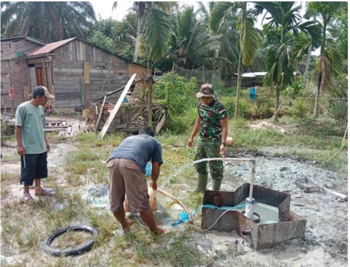
Pembuatan Sumur Bor Program Unggulan Kasad di Dusun 14 Desa Selat Beting
